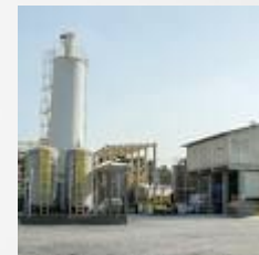
Tratamento de água
